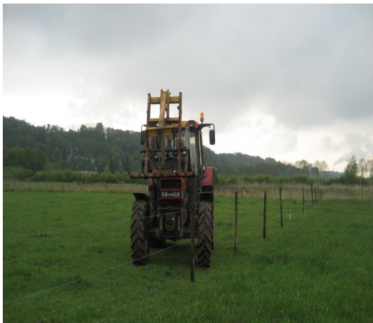
Kastanjehoute palen worden de grond in gedrukt,
